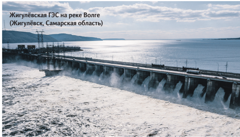
Жигулёвская ГЭС на реке Волге (Жигулёвск, Самарская область)
