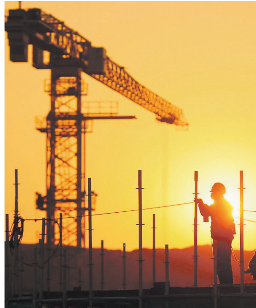
Строительная площадка третьего энергоблока атомной электростанции «Суйдабао»
